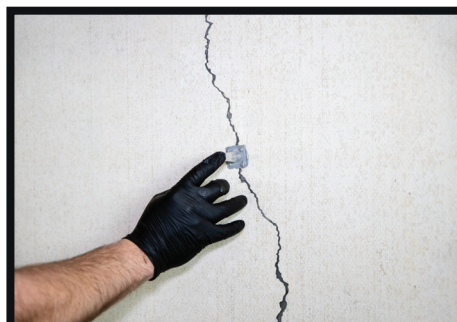
02 : En appuyant fermement, placez le port d'injection directement sur la fissure.
