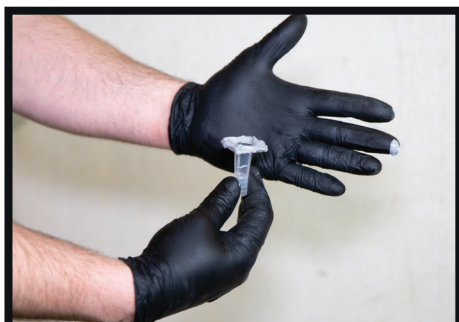
01 : Roulez le port d'injection dans la PÂTE DE PRÉPARATION DE SURFACE POUR RÉPARATION DE FISSURES BARRICADE MC RÉPARATION DU BÉTON.
